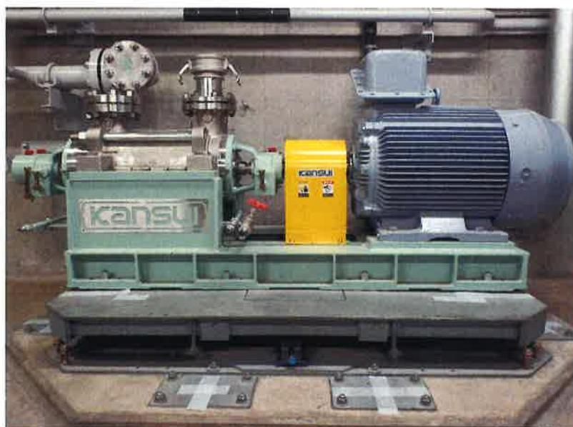
【図表 4 1 蒸気発生器補給用仮設中圧ポンプ】
